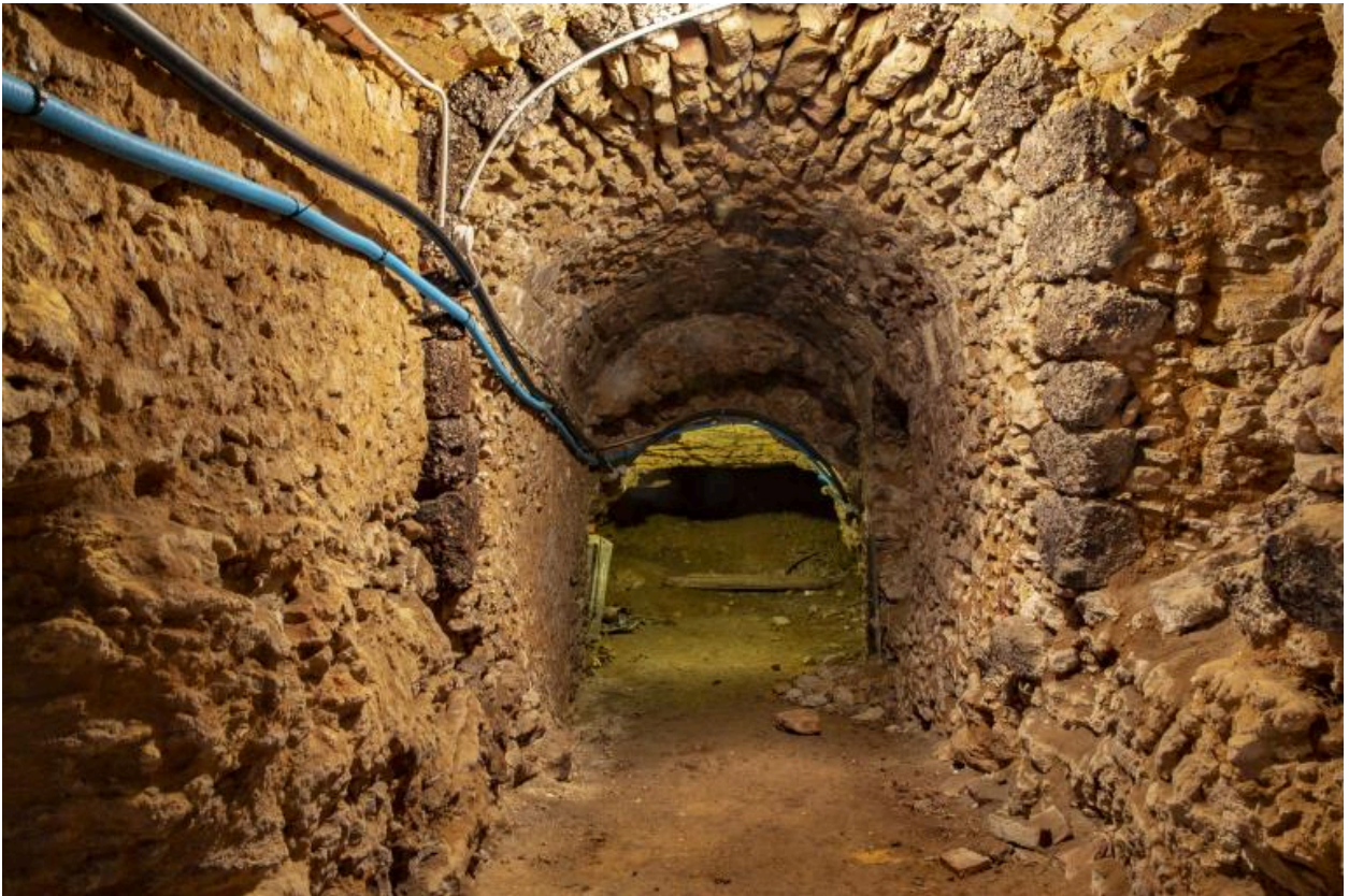
Le départ de souterrain.
