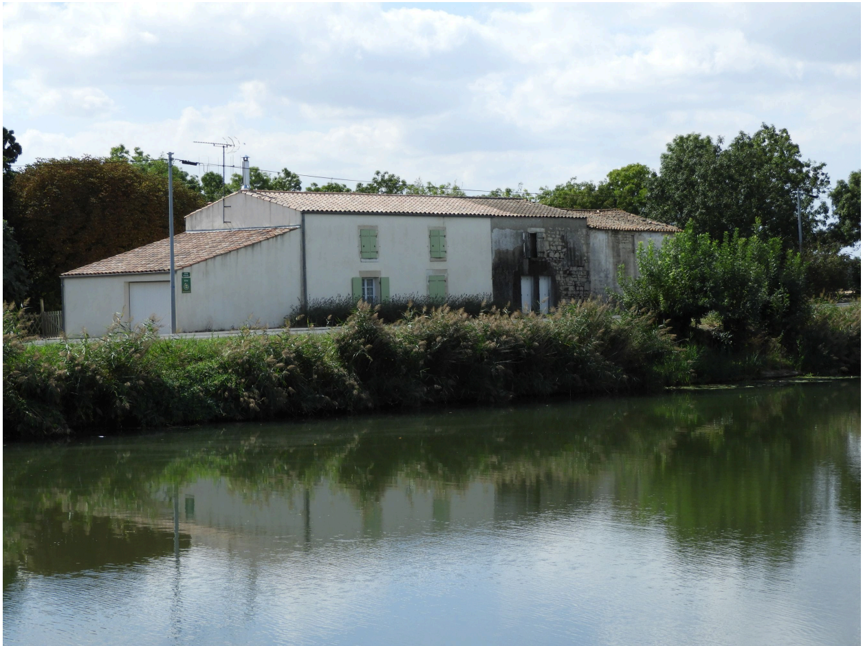
La Victorine vue depuis le nord-est.
