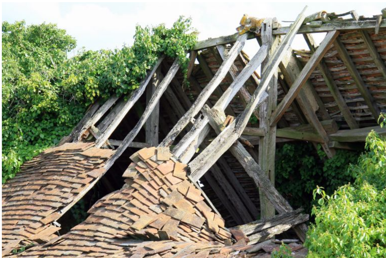
La vieille maison : charpente à pannes.
