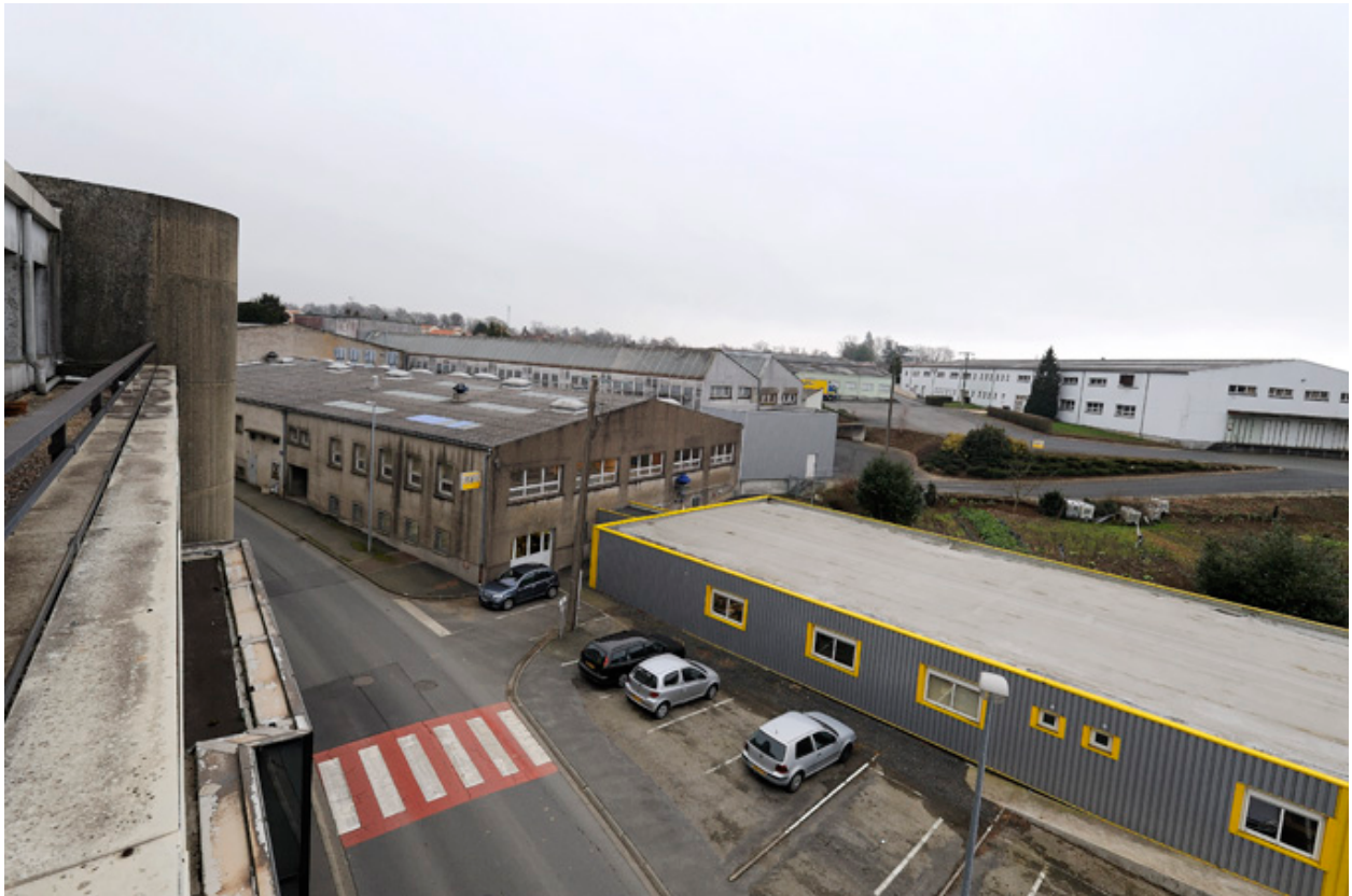
Usine Mogeco (U3), vue depuis le quatrième niveau de l'usine Taïga (U1).
