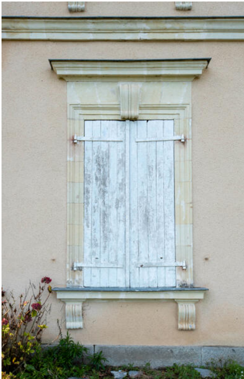
La façade sur le parc, détail d'une fenêtre.
