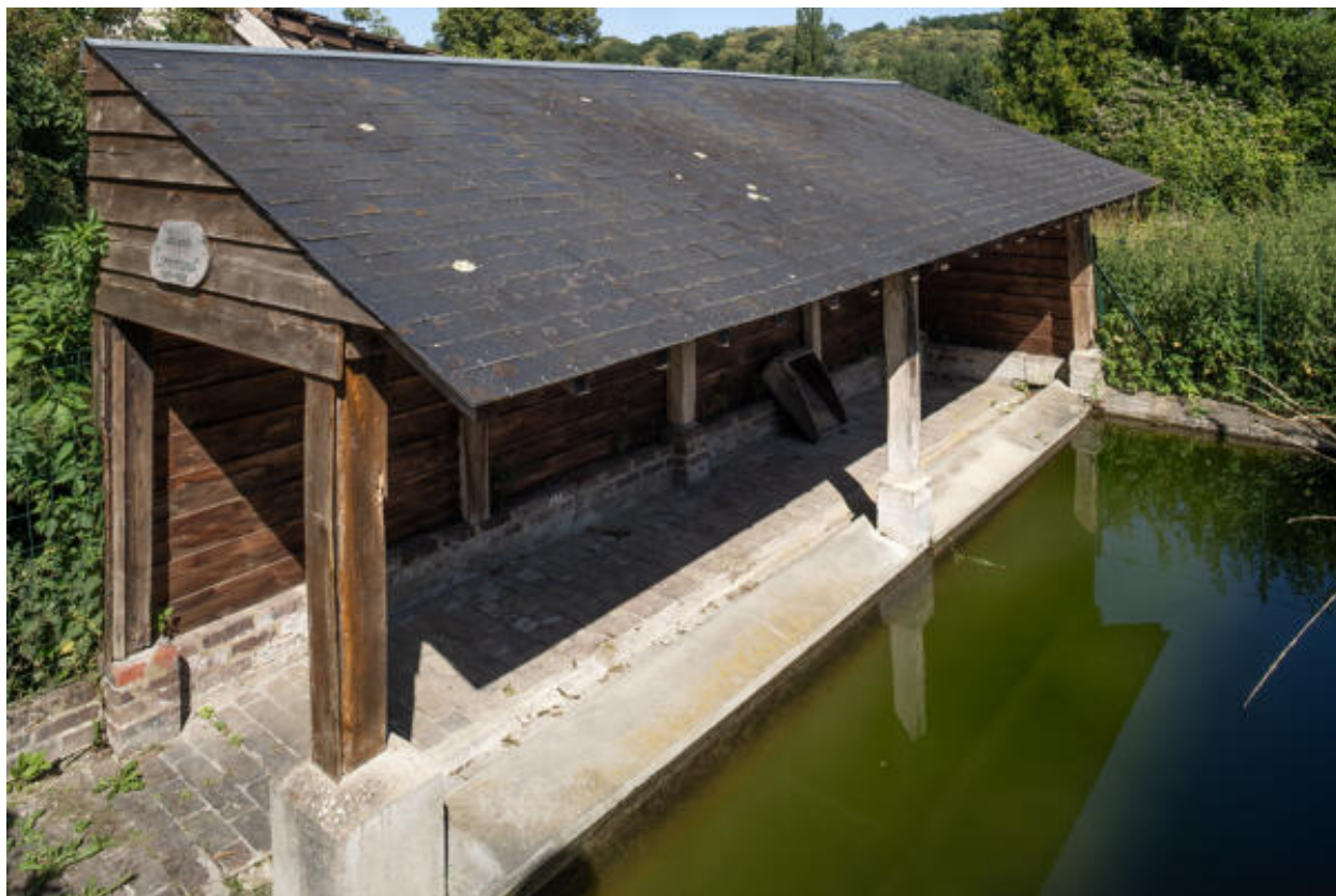
Vue sur l'abri en appentis et le bassin.
