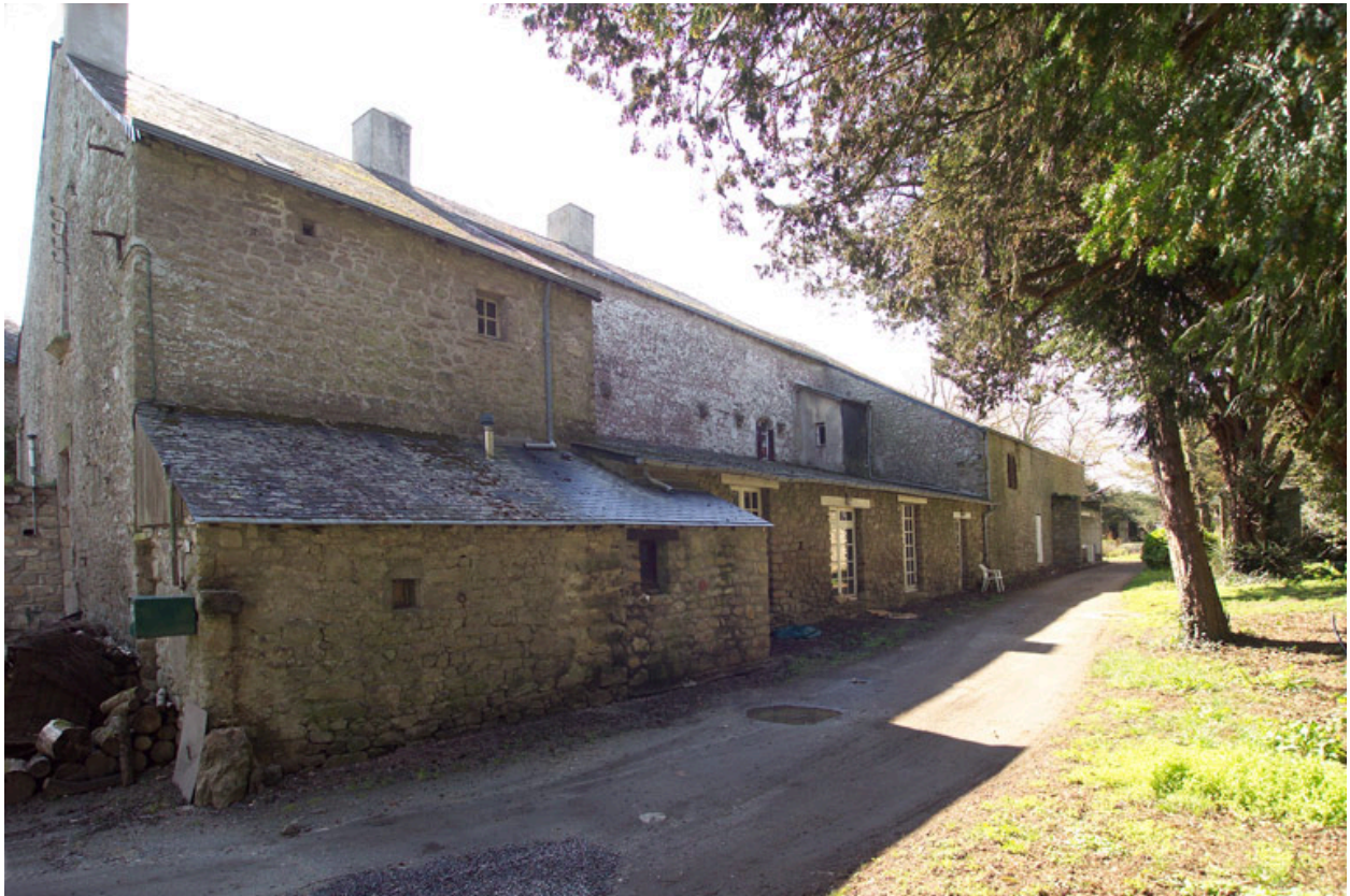
Élévation postérieure du logis, vue de trois-quarts depuis l'est.
