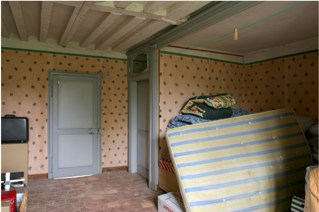
Etage de comble, pièce sud : l'alcôve et le mur est.
