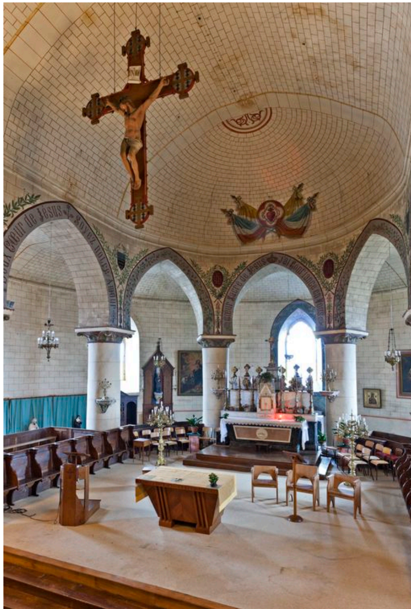
Chœur et déambulatoire. Monument aux morts, vue depuis le chœur.
