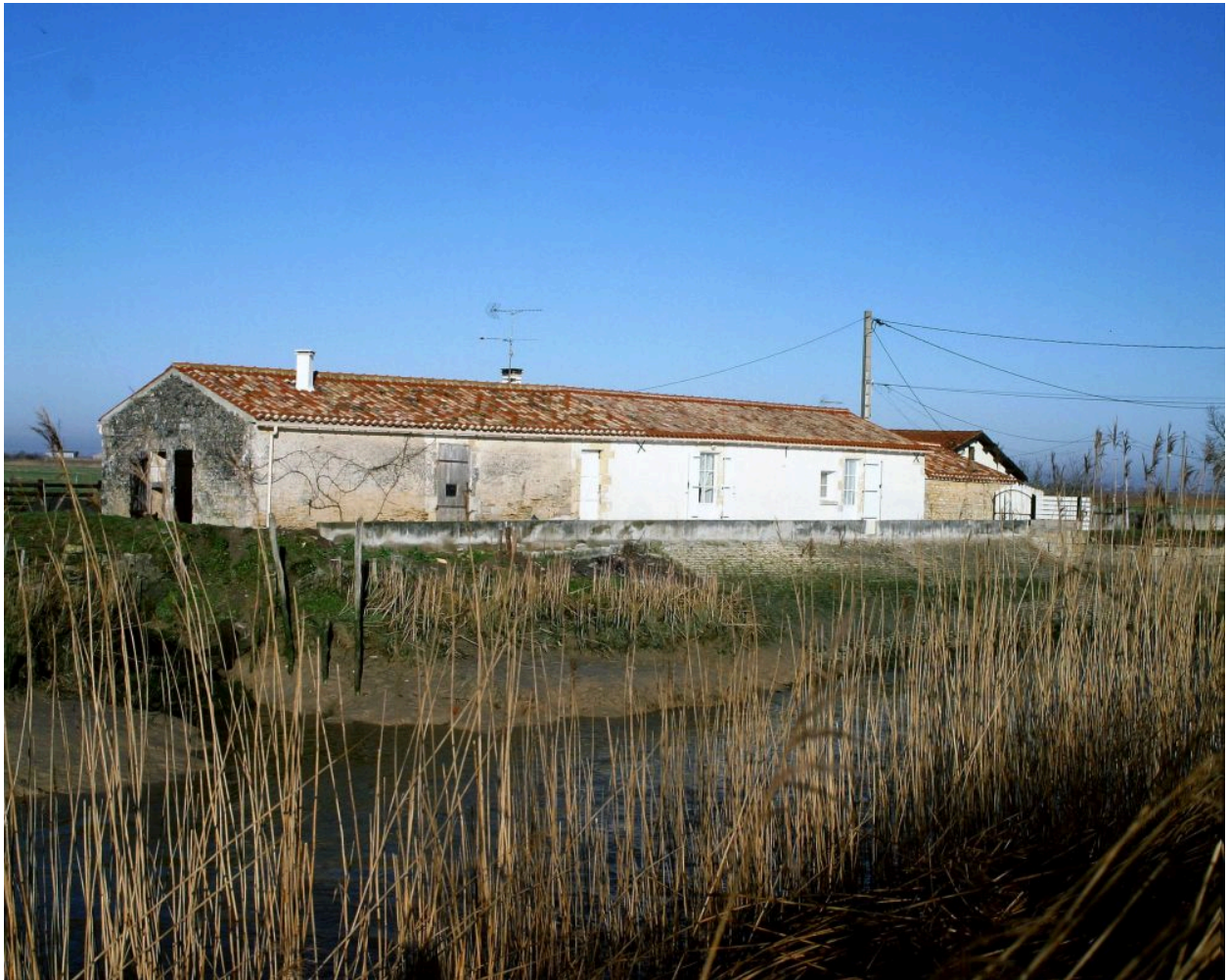
L'ancienne maison de garde vue depuis le sud-ouest, en aval.
