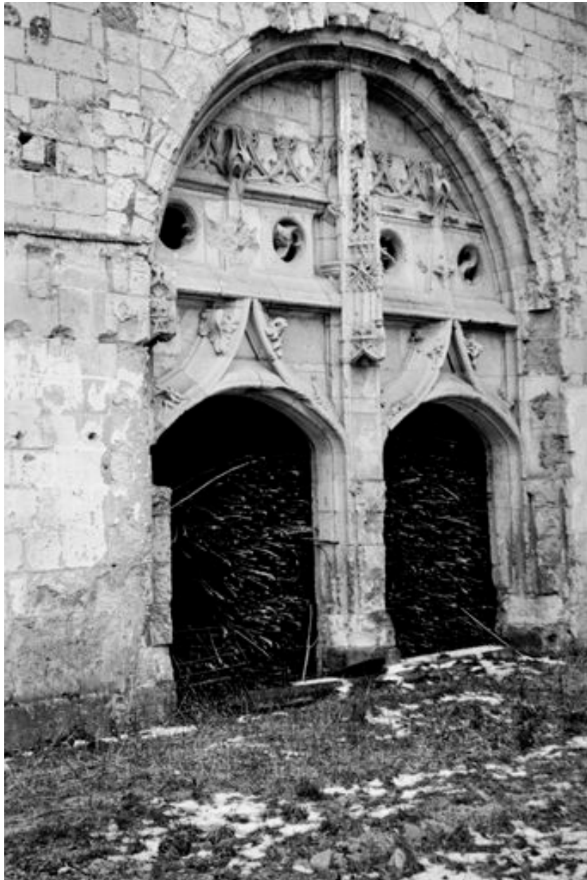
Abbatiale, bras nord du transept, face ouest, portail flamboyant, état vers 1963.
