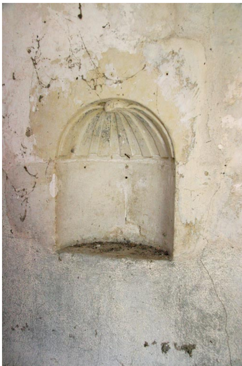
La chapelle Saint-Louis : niche servant d'armoire eucharistique.
