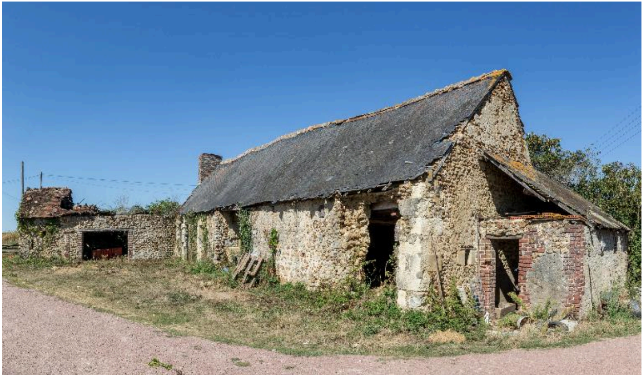
Ferme ancienne et grange-étable (ou remise ?) en retour d'équerre.
