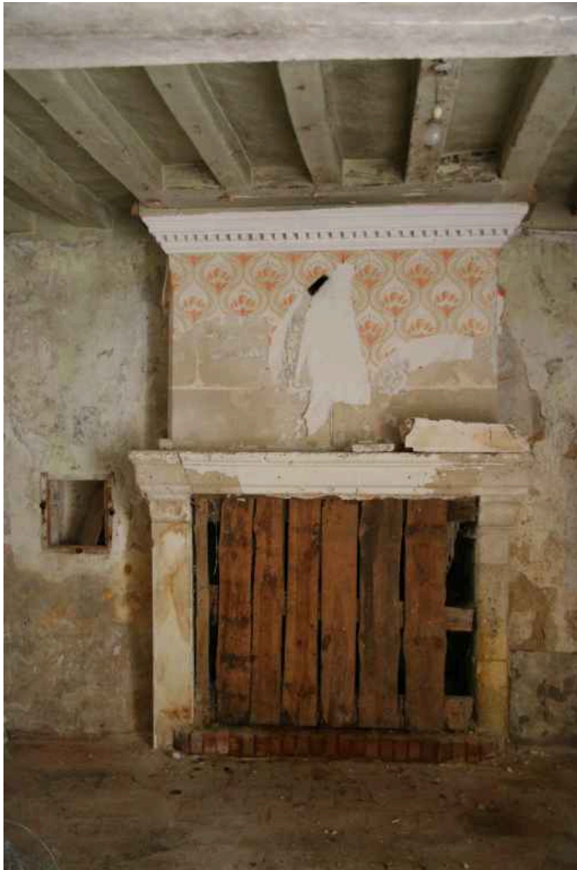
Rez-de-chaussée : cheminée nord.
