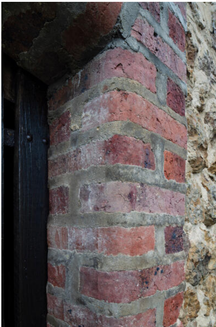
Cellier : détail de la porte extérieure.
