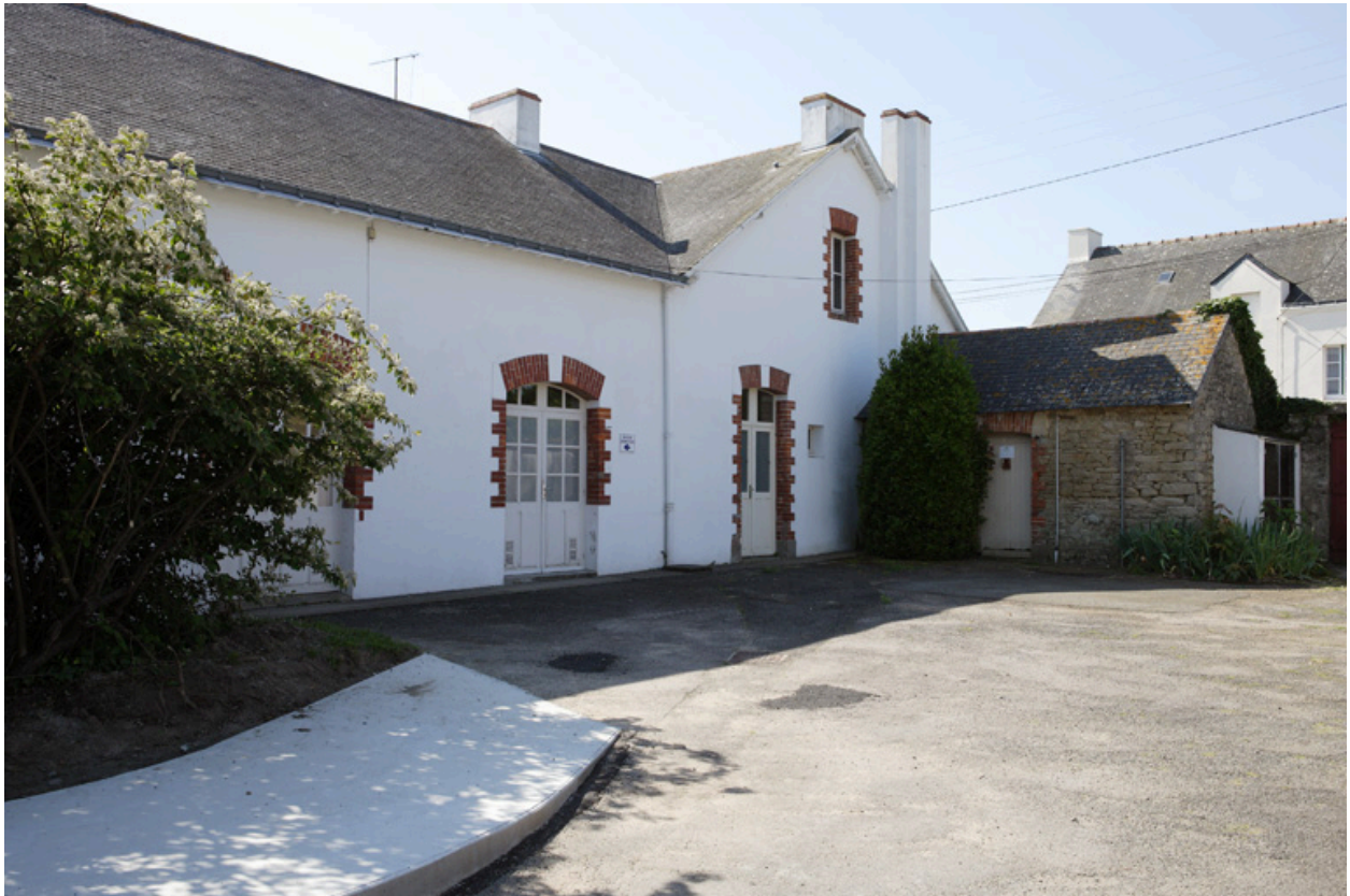
Vue de la façade ouest depuis le nord.
