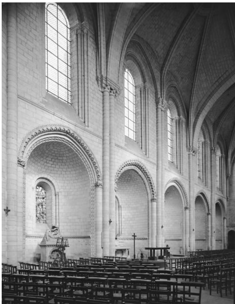
Elévation nord de la nef.
