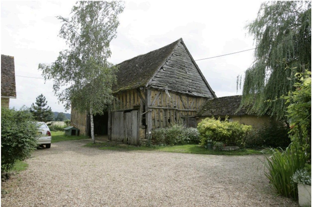
Grange-étables-remise, vue depuis la cour.
