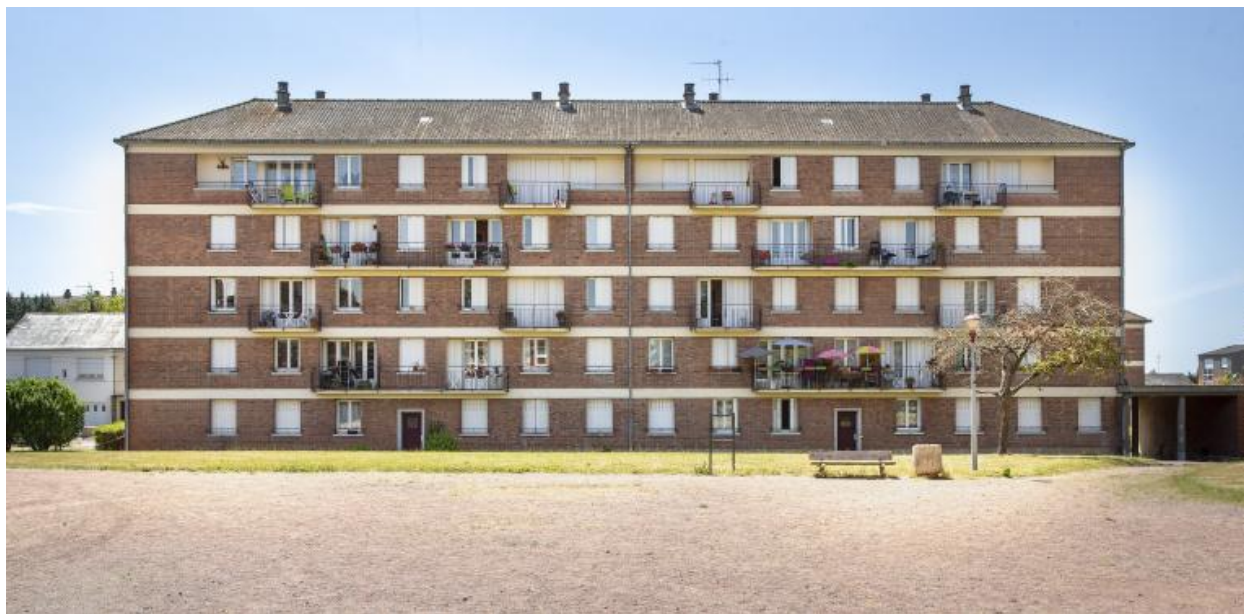
Vue de la façade du bâtiment C depuis les espaces verts.
