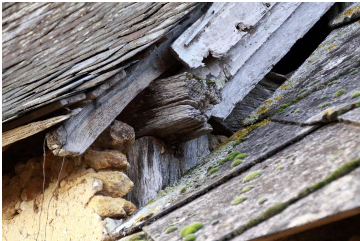
Maison et dépendance, détail au raccord des toits : structure en bois.
