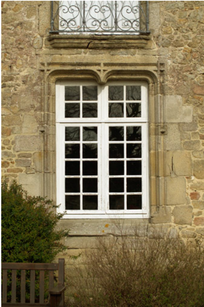
Croisée au premier niveau de la travée centrale sur l'élévation antérieure du logis.
