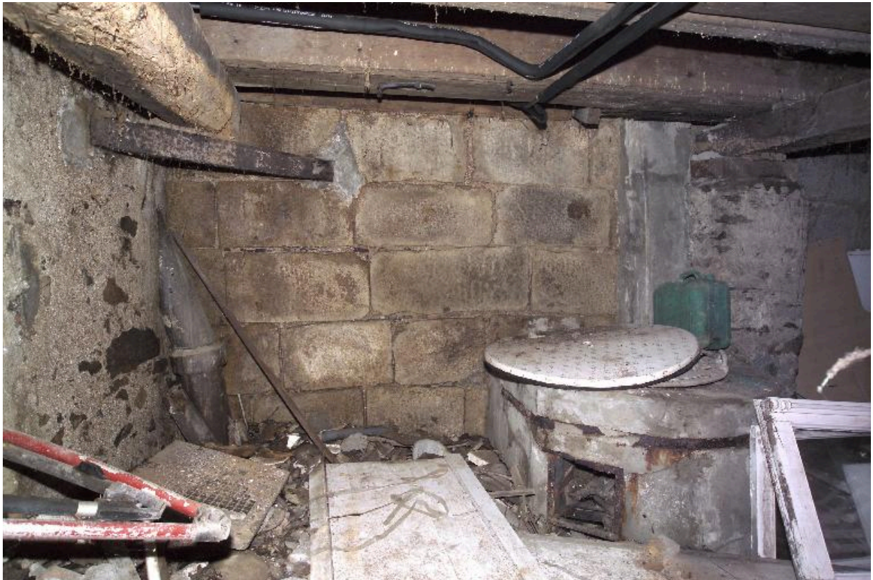
Le corps de bâtiment sur le quai, le niveau des caves, détail du parement de granite du mur mitoyen avec la maison n° 44.
