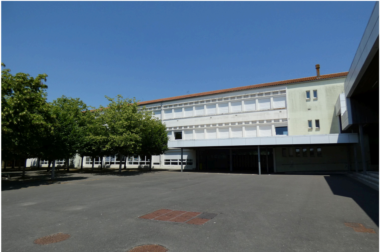
Le grand bâtiment de classes vu depuis le sud.
