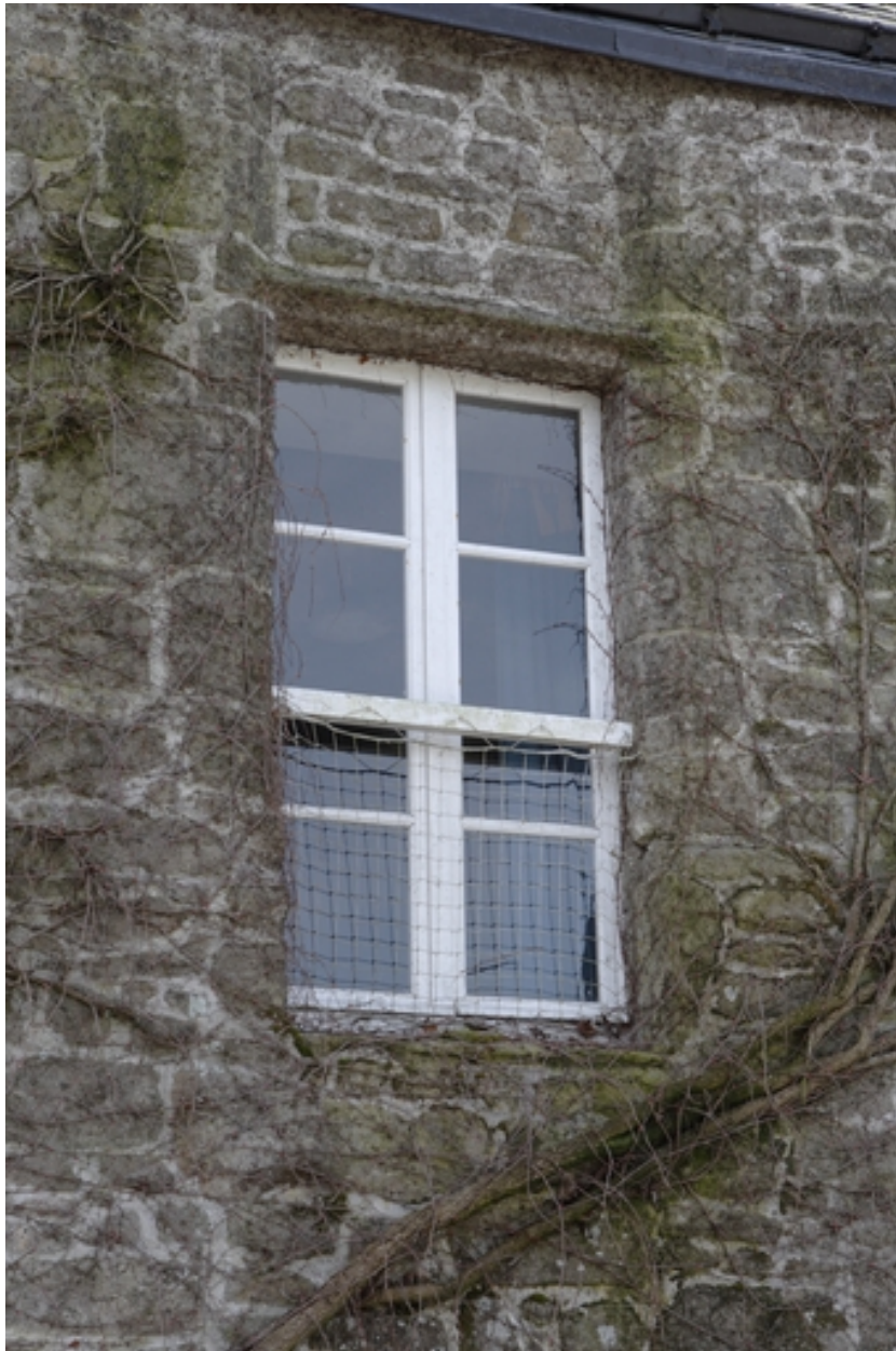
Façade nord. Premier étage. Détail de la croisée de la salle haute.
