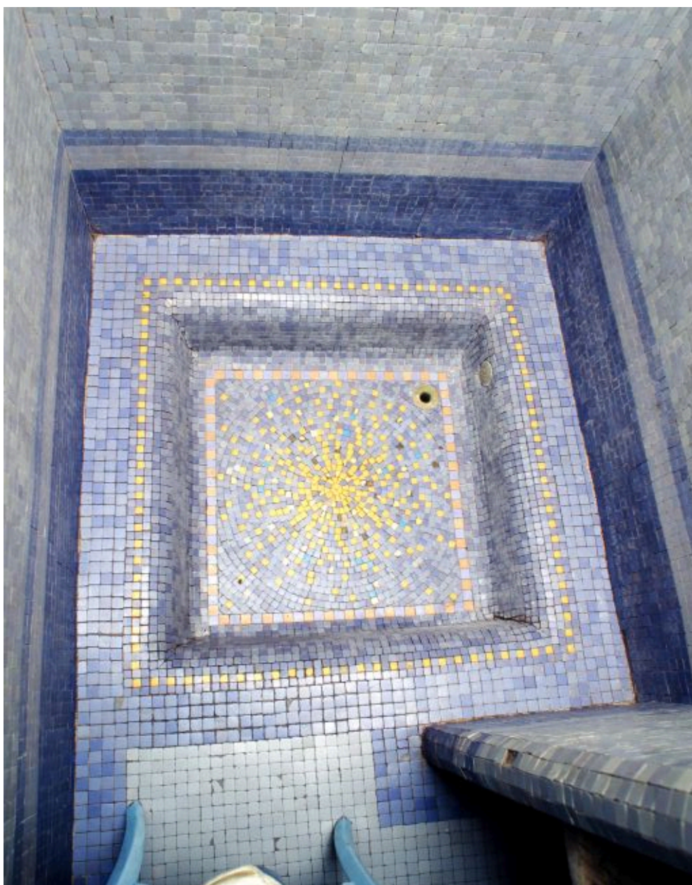
Intérieur, cabine de douche, vue de détail : bac.
