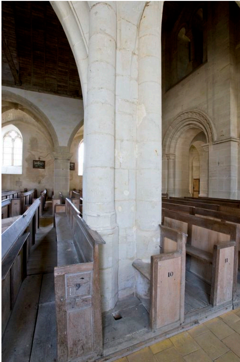
Pilier entre les 2e et 3e travées du bas-côté nord
