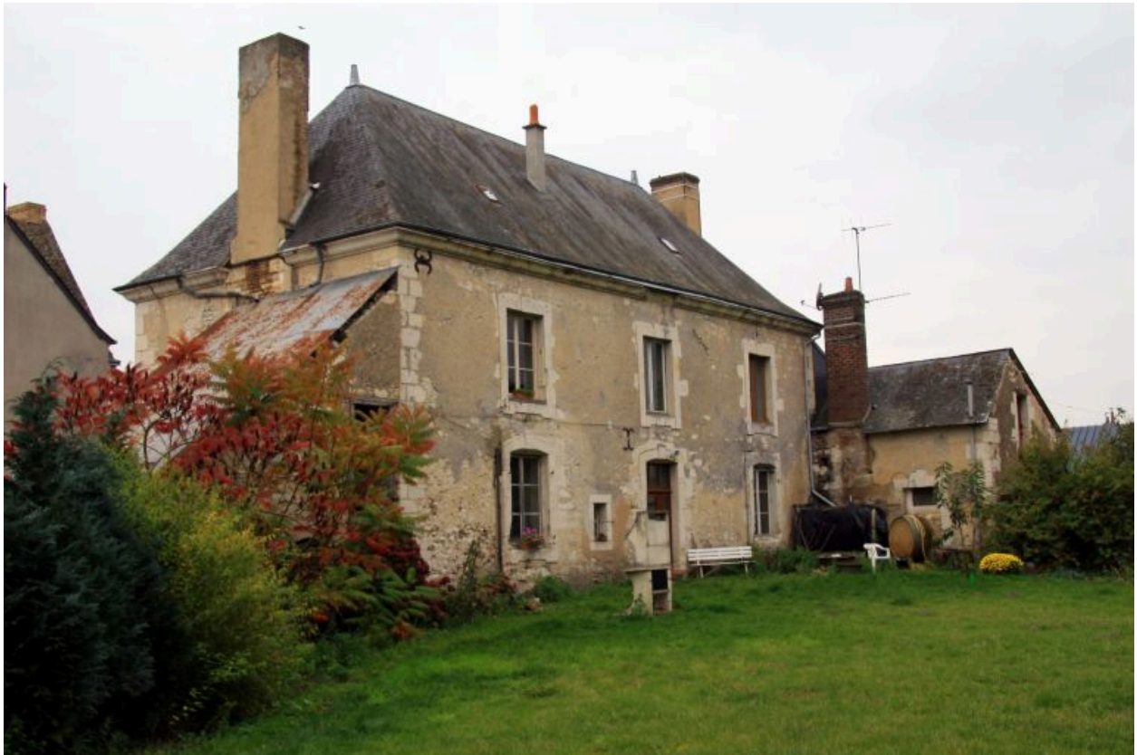
Façade sur cour.
