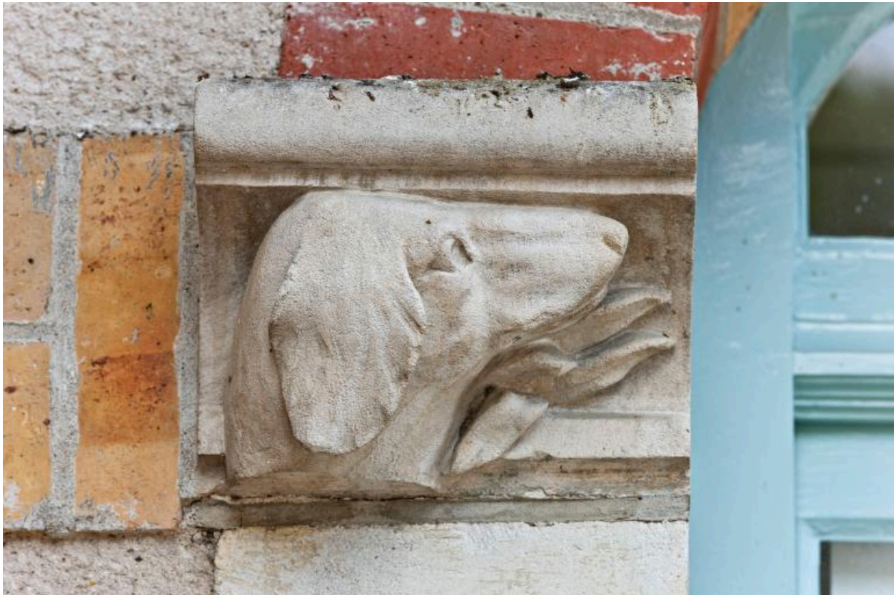
Tête de chien en ciment apposée à gauche de l'actuelle porte d'entrée.
