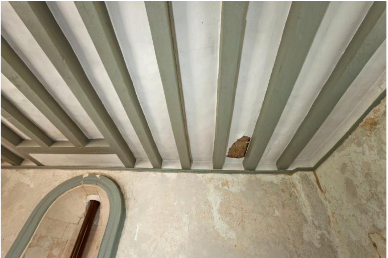
RdCh, salle ouest : poutraison.
