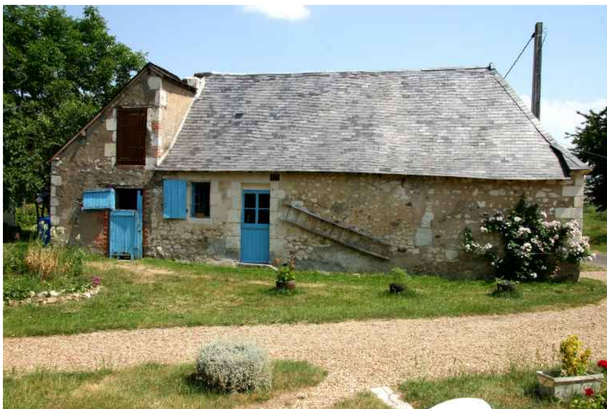
Maison 3 : façade antérieure.
