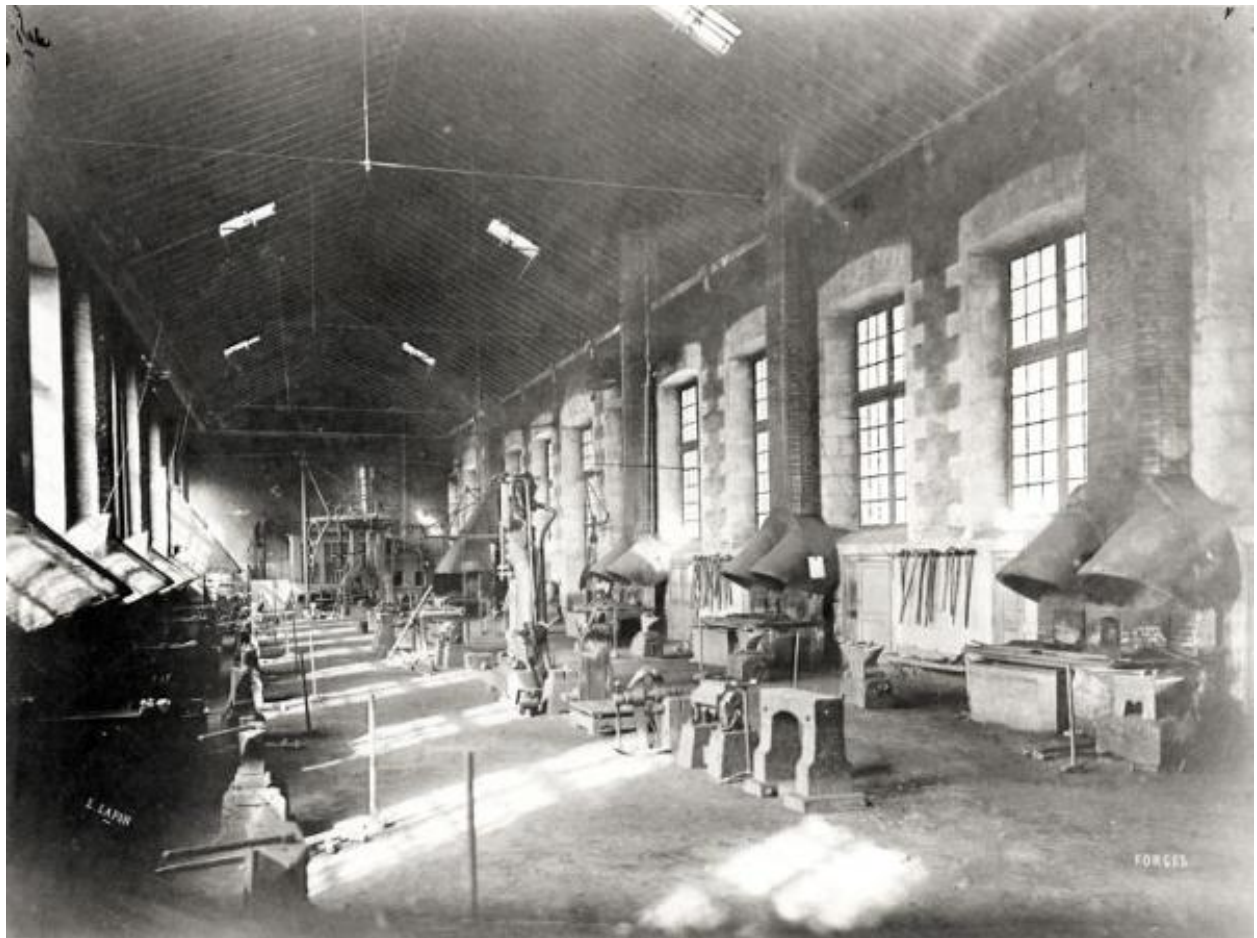
Ecole des Arts-et-Métiers : atelier des forges, fotogr., de L. Lafon, début 20e siècle. (AD Maine-et-Loire ; 5 Fi 4).
