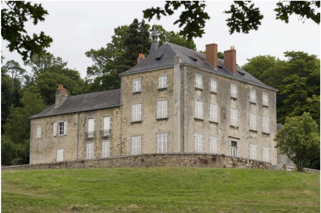
Le château : vue d'ensemble depuis le sud-ouest.
