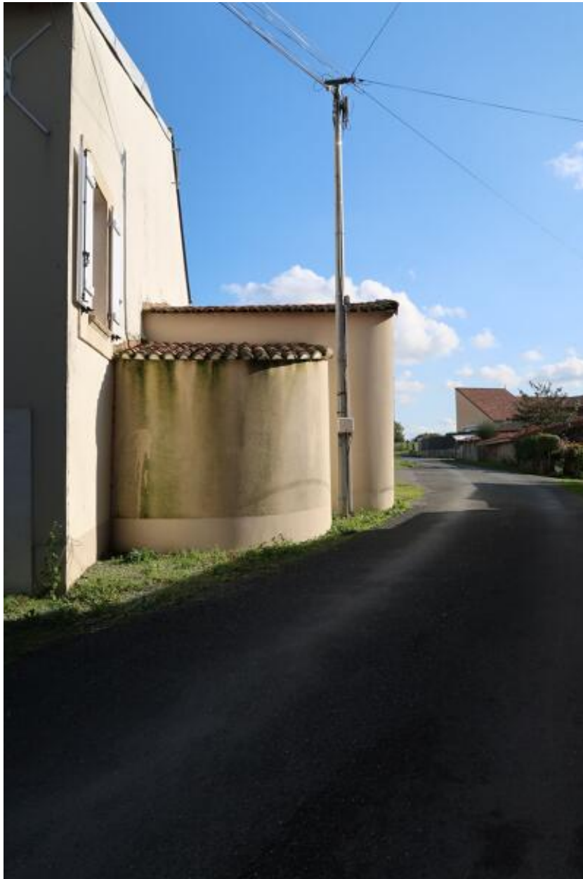
Rangée de fermes n°2. Détail d'un four à pain.
