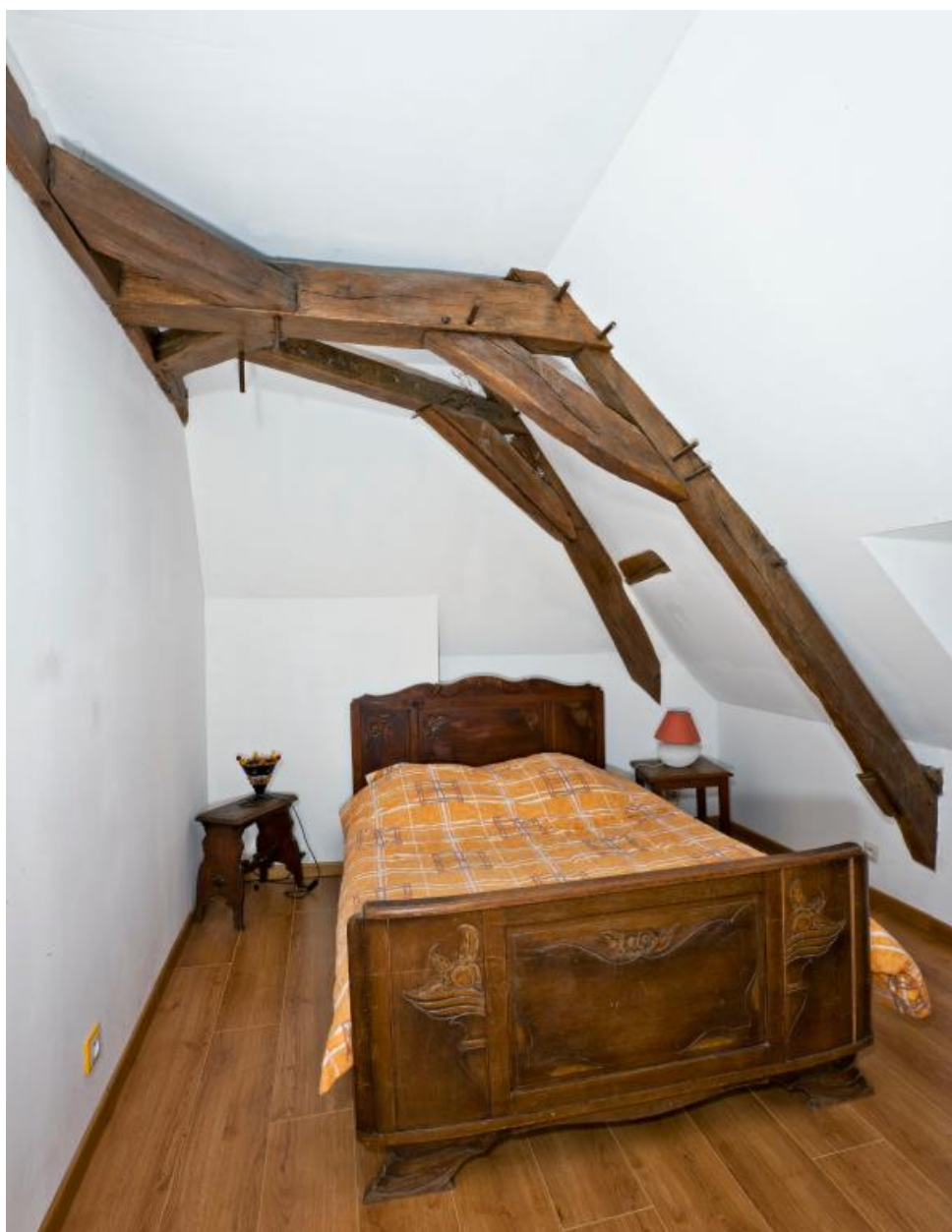
Maison, comble : détail de la charpente.
