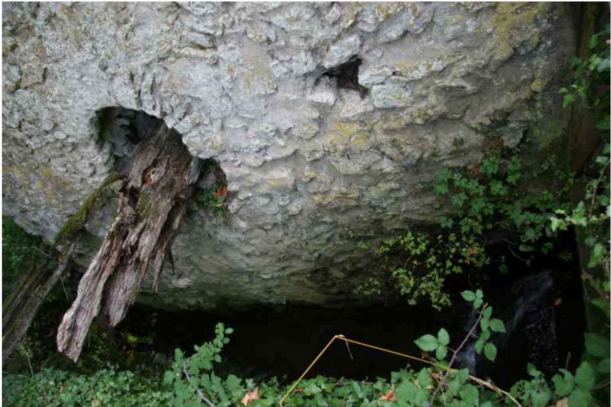
Pignon du moulin : arbre de la roue.
