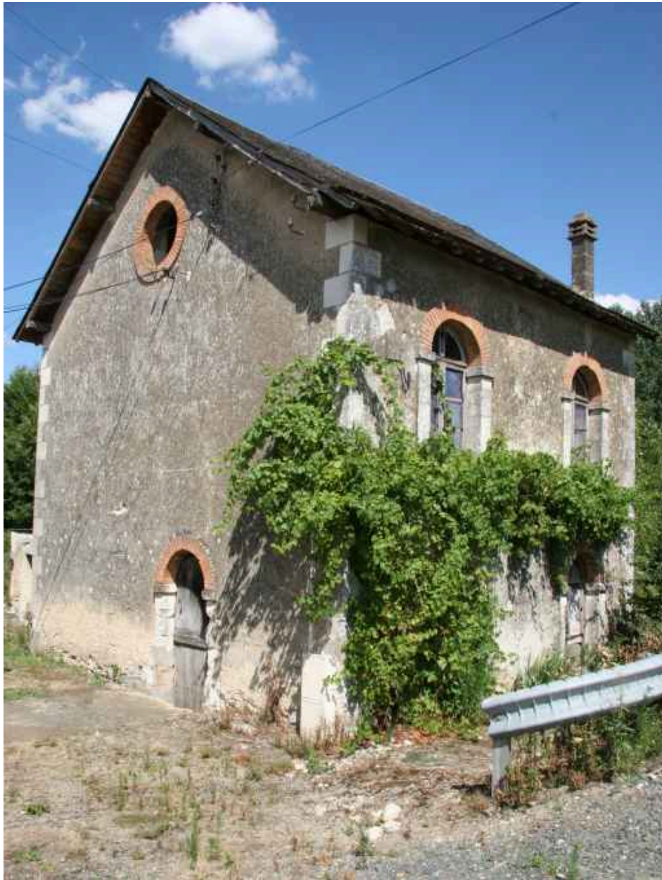
Vue de volume du moulin sur la rive gauche.
