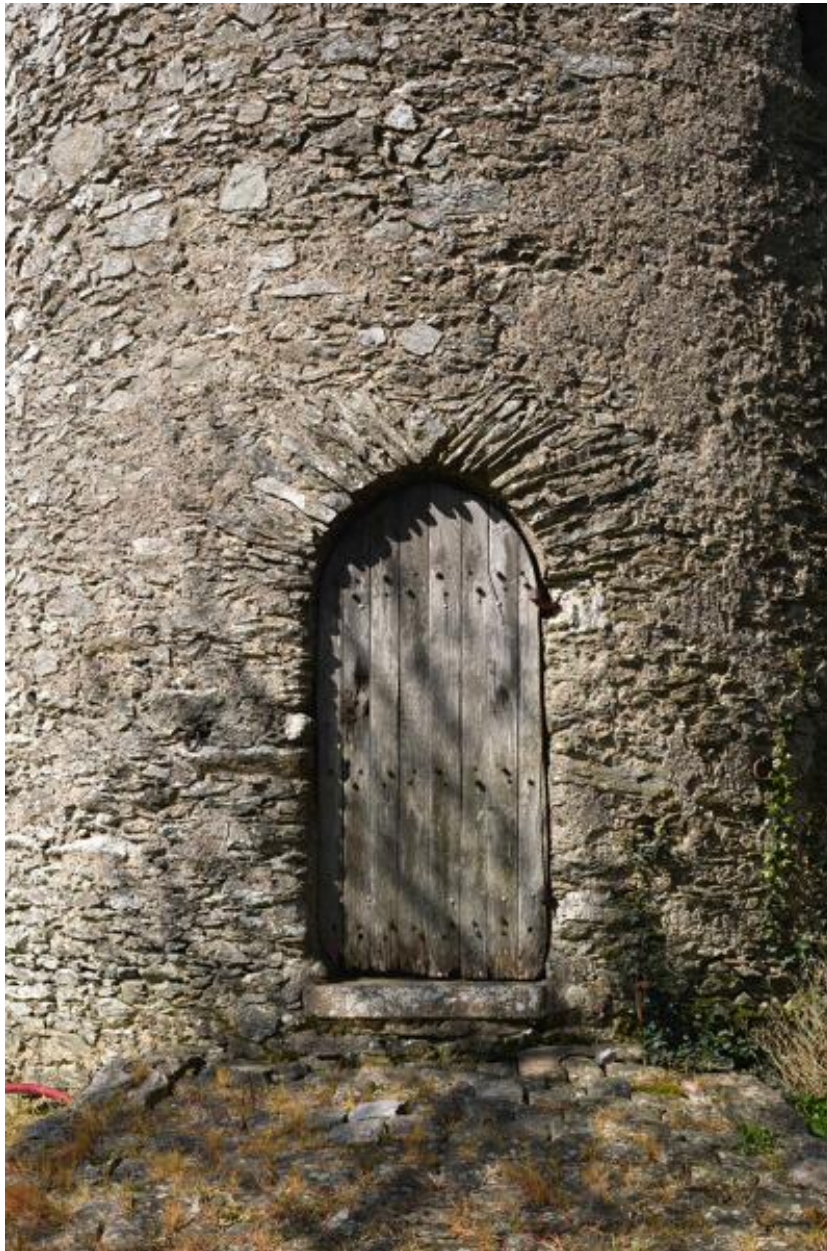
Moulin à farine dit moulin des Buttes (n° 1) ou moulin de l'Ouche-Neuve. Détail de la porte sud.
