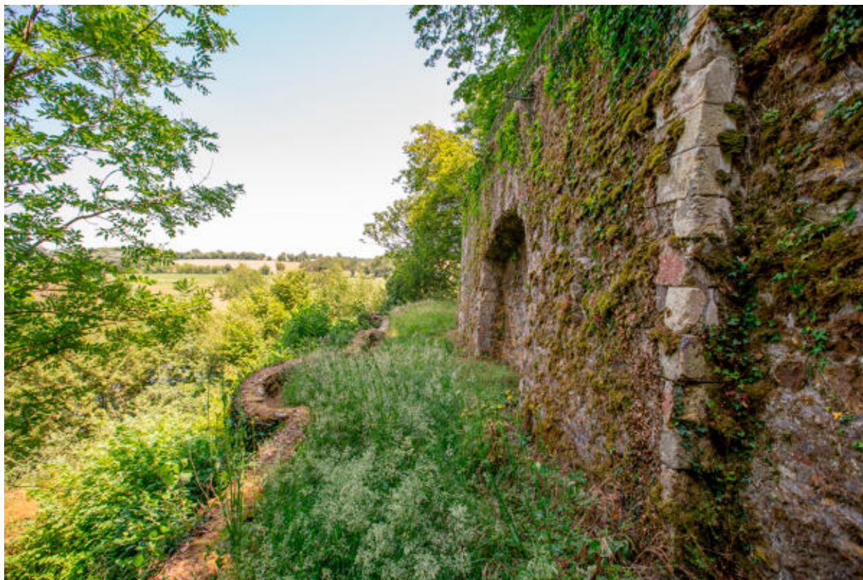
Le soubassement du belvédère.
