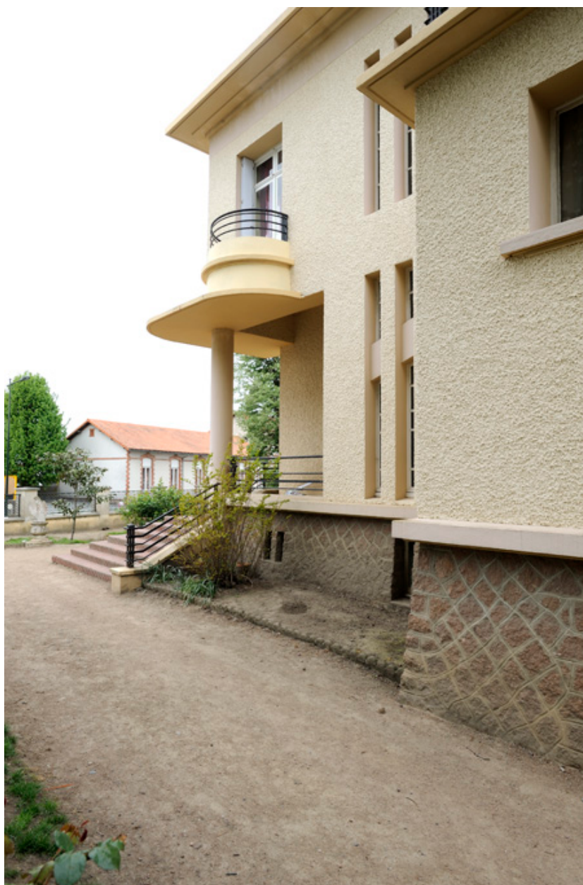
Maison d'Auguste Repussard : façade sud-ouest.
