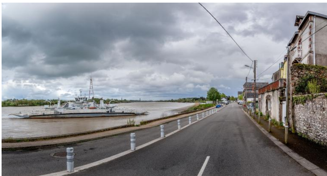
Vue générale du quai des Coteaux.
