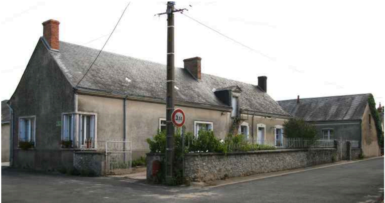
Rue Altéa : maison de type rural remaniée 3e quart du XIXe siècle.
