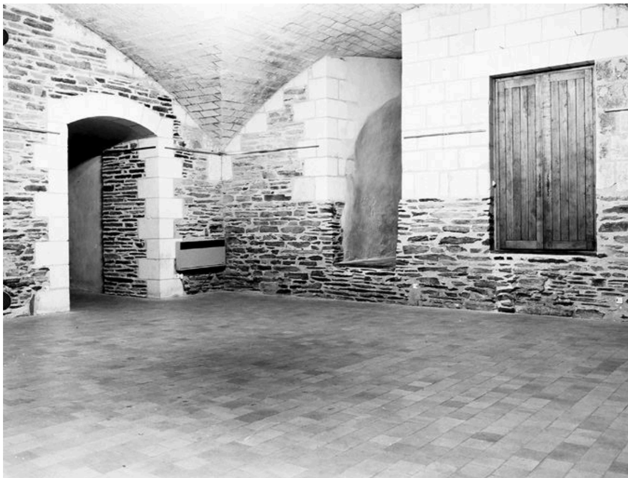
Tour-clocher dite tour Saint-Aubin, salle basse : angle nord-ouest.
