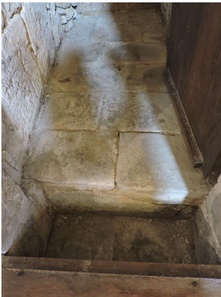
Premières marches de l'escalier conduisant du choeur aux voûtes.
