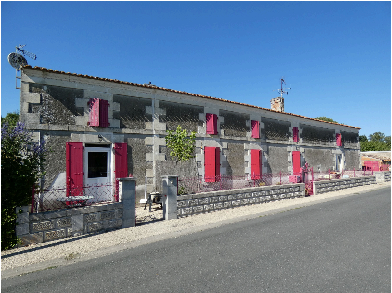
Le logis vu depuis le sud-ouest.
