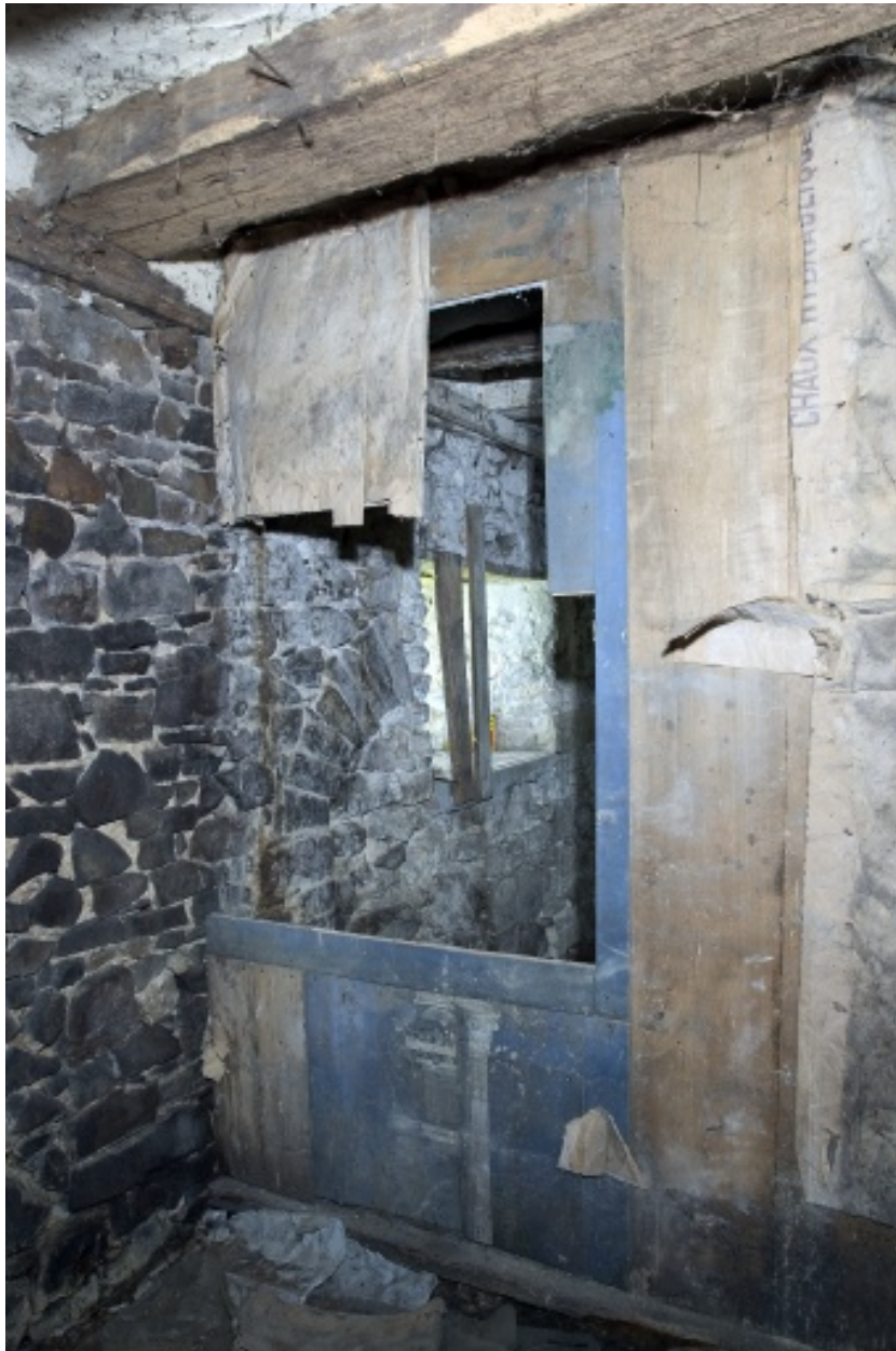
Intérieur du corps nord, rez-de-chaussée, cave est : la porte bouchée du mur nord.
