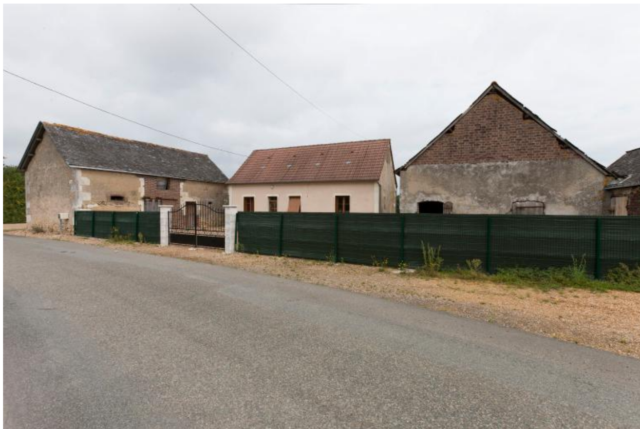
Ferme à bâtiments disjoints, en U. Le Petit Chêne sec.
