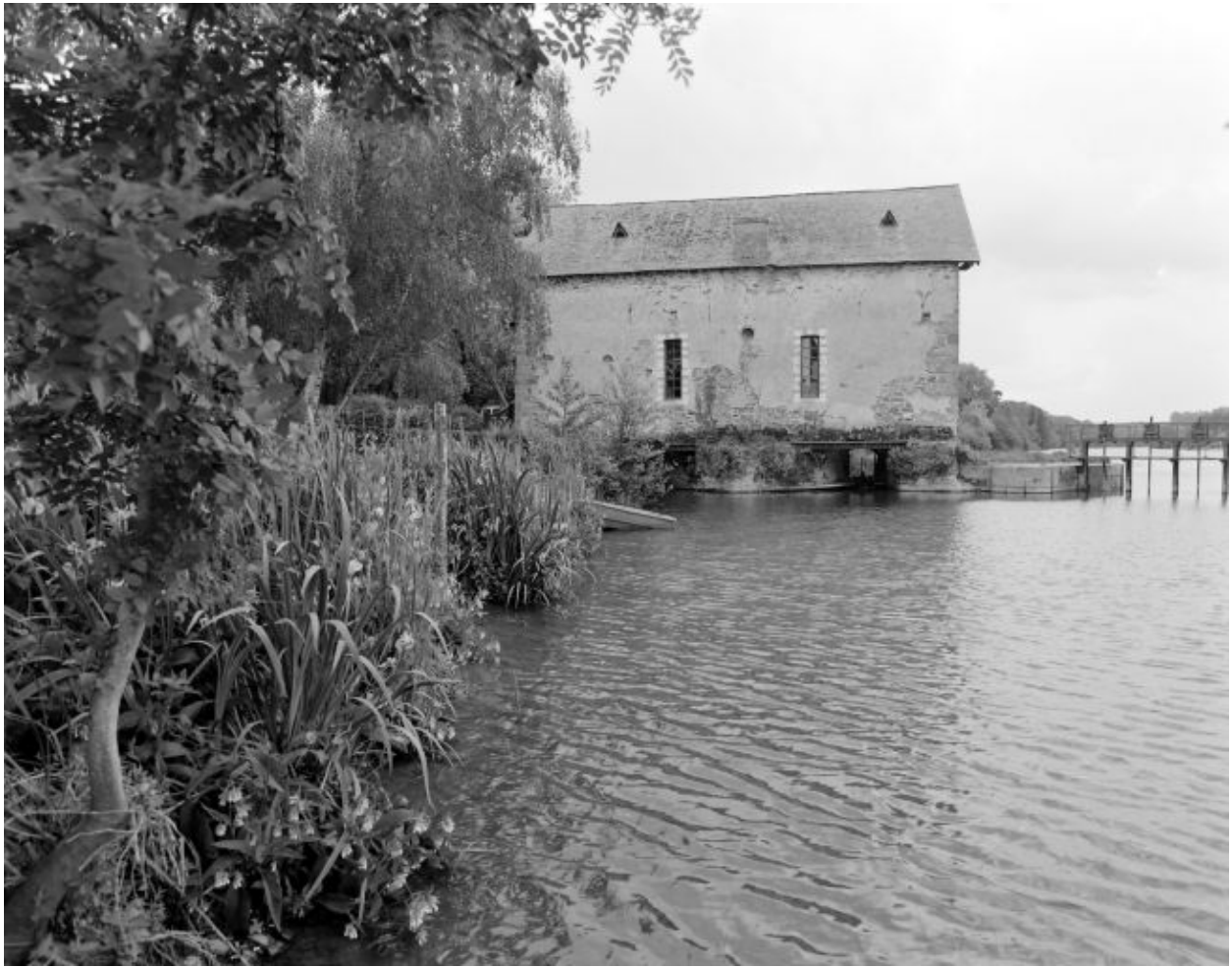
La façade nord et les entrées des coursiers vus d'amont.
