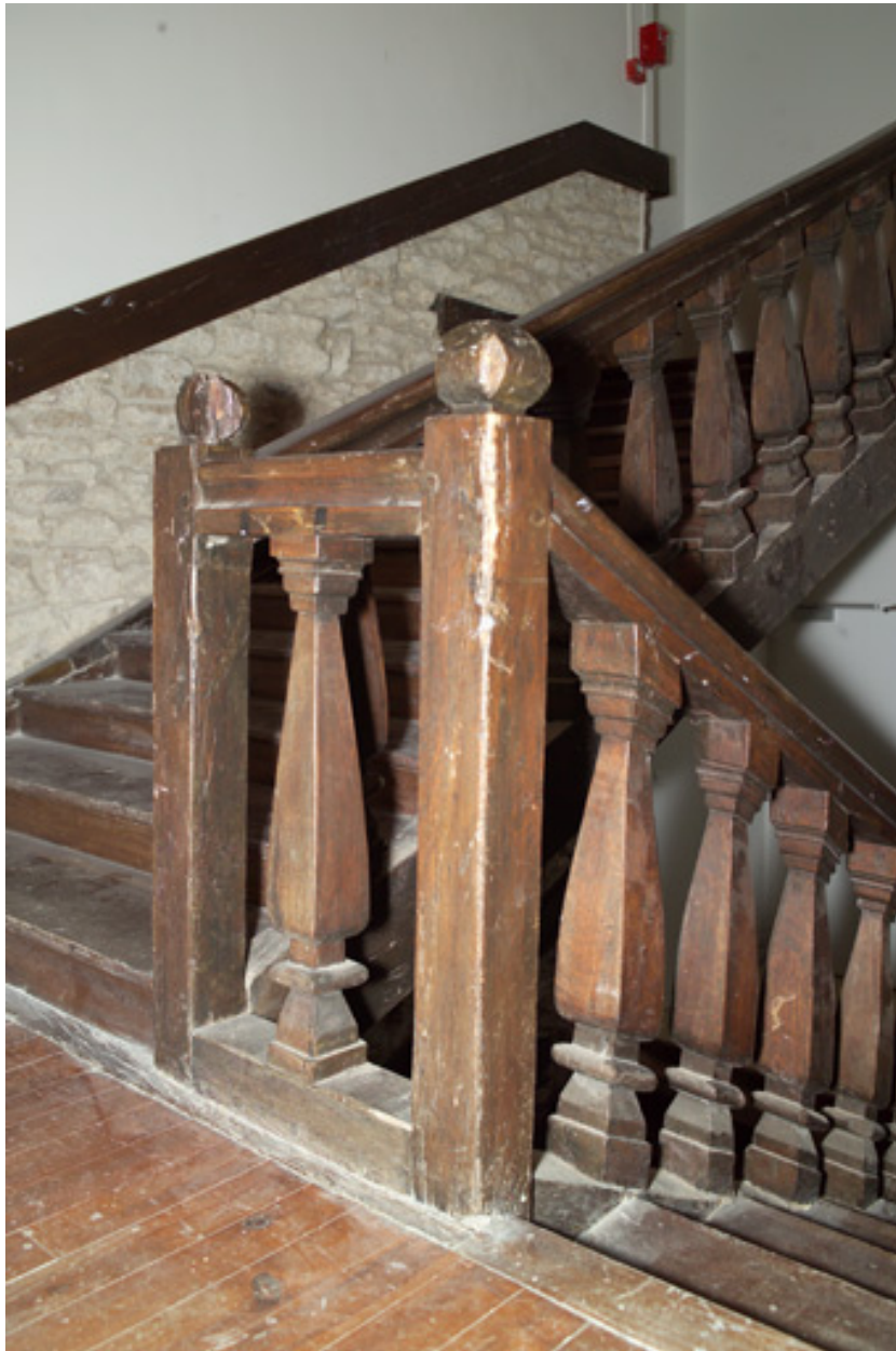
Détail des balustres de l'escalier en bois du bâtiment est.
