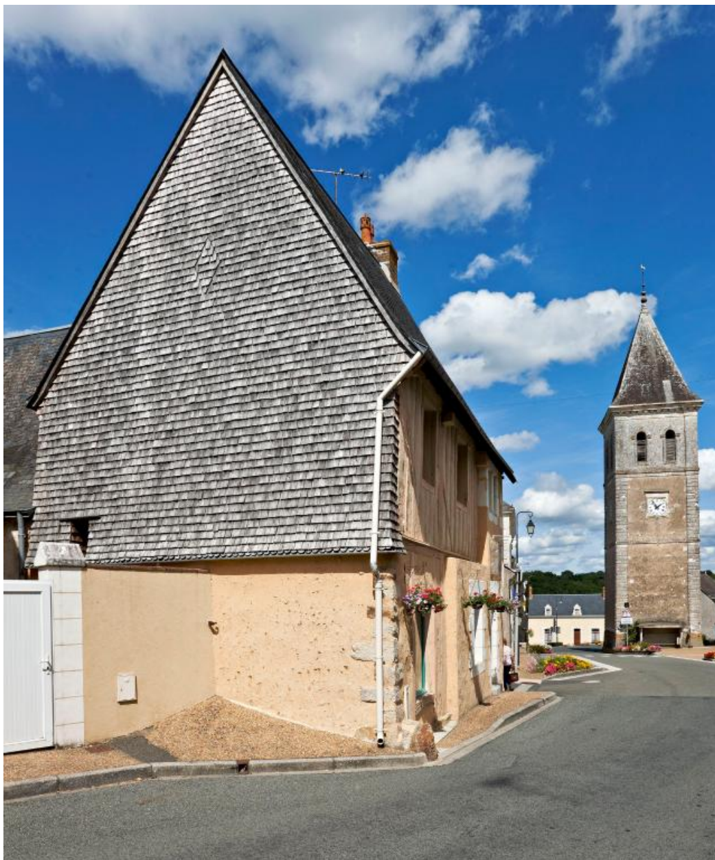
Maison du Pilier Vert : mur-pignon sud.
