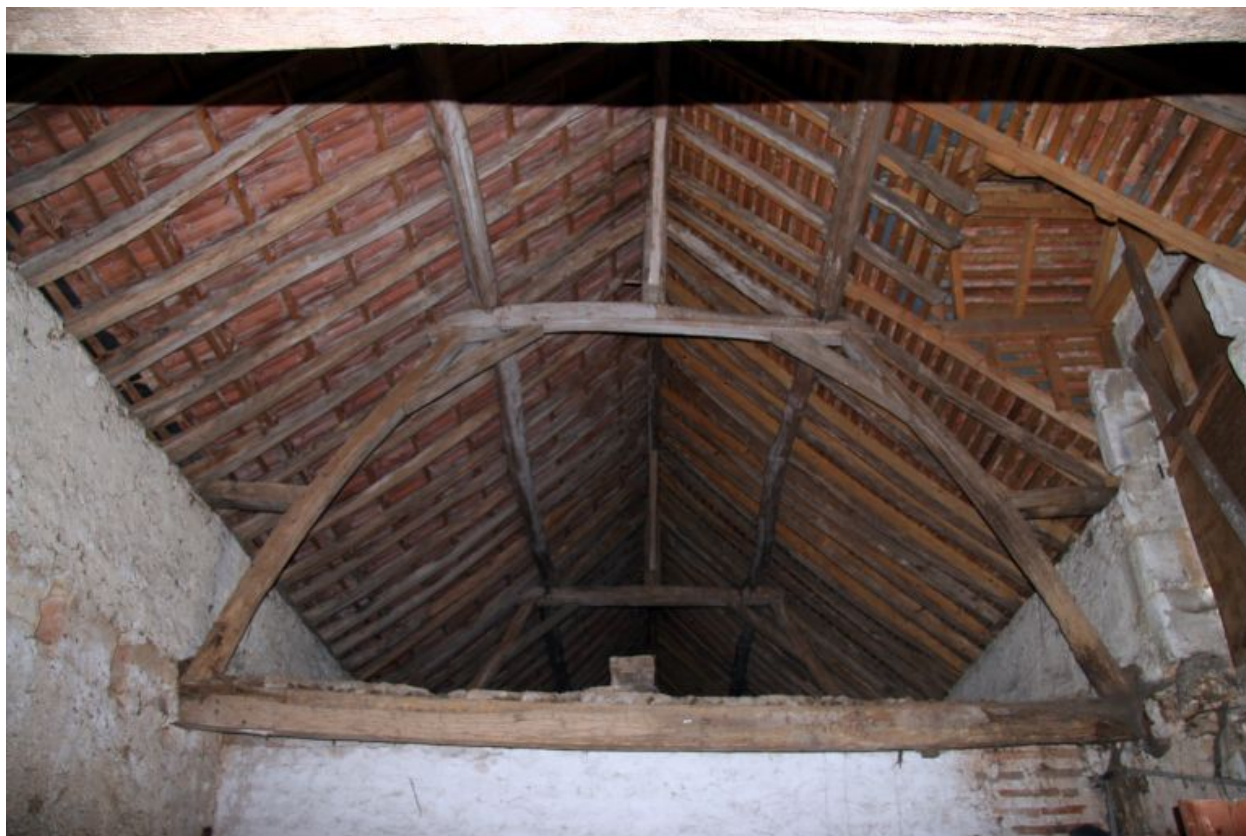
1 impasse, ferme : charpente de la grange.
